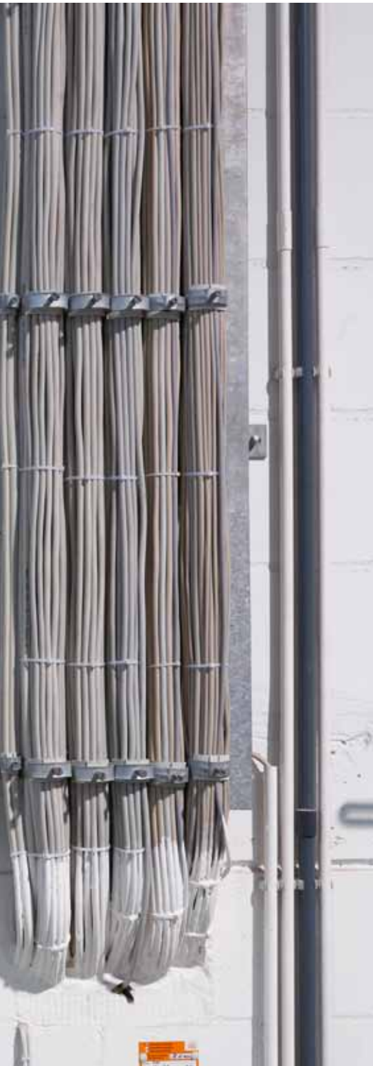
rechts oben: verschiedene Abschottungen für unterschiedliche Anforderungen rechts unten: Kabelbandagen zur Verhinderung der Brandweiterleitung über Brand-schutzwände
