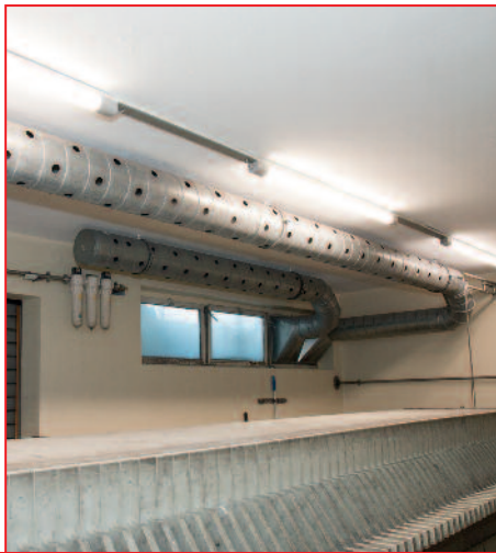
Die alte Beleuchtung ist in die Jahre gekommen: Die Wanneneuchten mit 2x58 W Leuchtstofflampen (7718) werden Schritt für Schritt auf das Modell Planox Eco LED (7721) von RZB umgerüstet.
