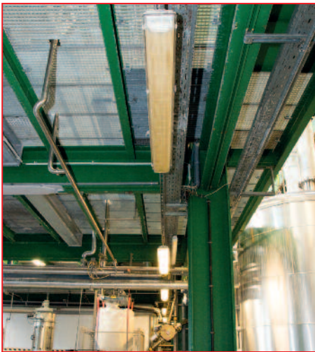
Die alte Beleuchtung ist in die Jahre gekommen: Die Wanneneuchten mit 2x58 W Leuchtstofflampen (7718) werden Schritt für Schritt auf das Modell Planox Eco LED (7721) von RZB umgerüstet.
